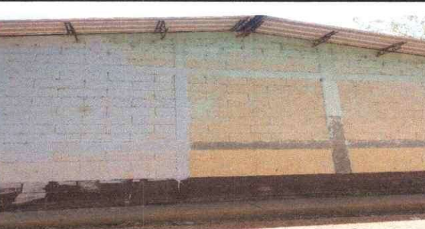
Foto 6: Se observa el deterioro de pintura interior y exterior de las estructura portante de tres aulas.
