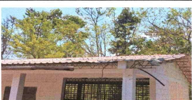
Foto 5: Se observa el deterioro de canales y bajadas de aguas pluvial de la estructura portante de tres aulas.
