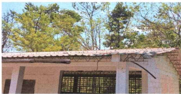
Foto 1: Se observa el deterioro de lámina de la estructura portantes de tres aulas.
